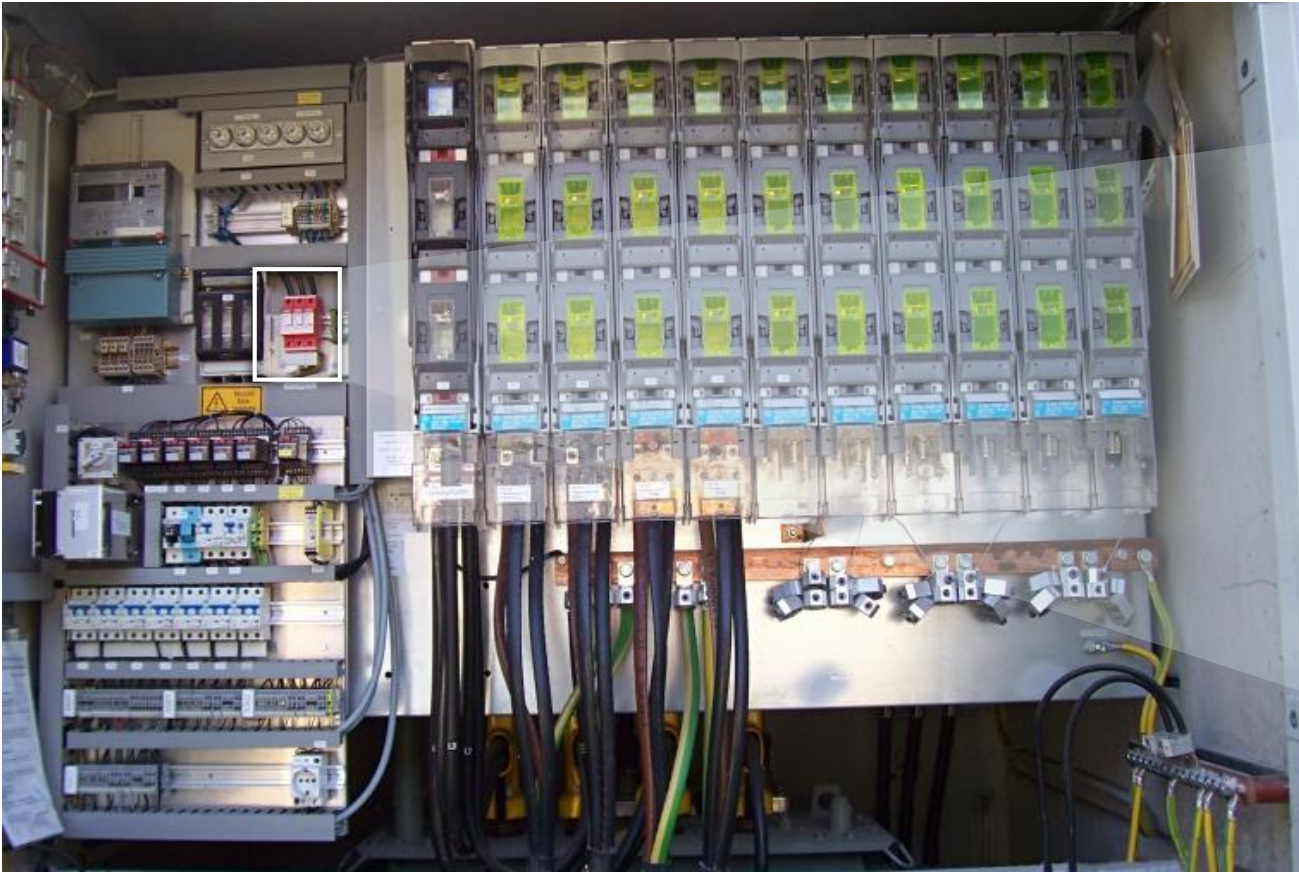
Niederspannungsseite einer fernbedienbaren Trafostation Überspannungsschutz durch DEHNGuard ACI
